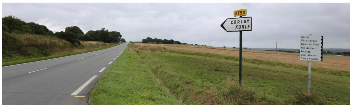
Photo 84 – La section de la RD790 en situation topographique panoramique
