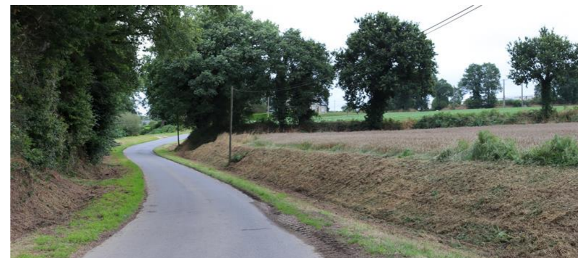
Photo 89 – En point bas les vues depuis le réseau routier sont fermées. Ici la RD8 dans la vallée du Blavet.
